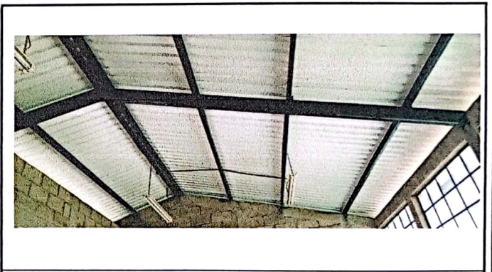
Foto 4: MATENIMIENTO DE TECHO Y ESTRUCTURA
